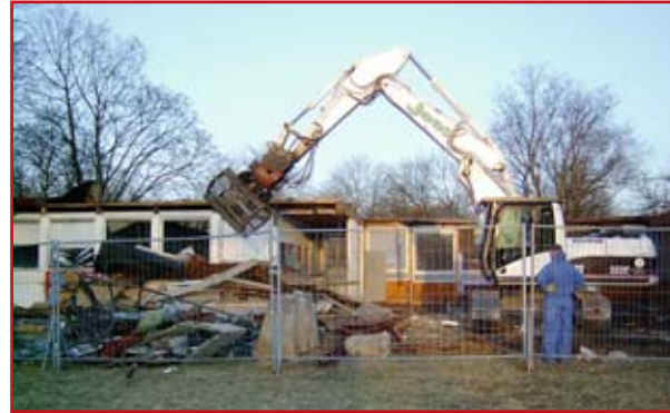
Der Abriss im März
