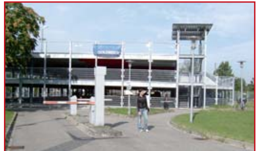
Bild oben: Haupteingang für PKWs zum neuen Parkhaus beim Städtischen Klinikum. Bild unten: Zugang von der Franz-Lust-Straße nur für Fußgänger. Fotos: I. Kosian
