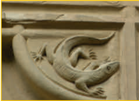
Oststadtfassade (Foto BF)
